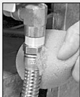
Após a instalação, abra o registro de gás e utilizando uma esponja com água e sabão, verifique se há vazamento em todas as conexões, incluindo toda a extensão da mangueira. Se houver formação de bolhas na conexão, refaça-a. Se houver bolhas em qualquer região da mangueira, efetue a substituição da mesma.
